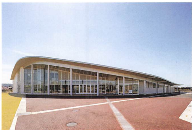
津幡町住吉公園屋内温水プール「アザレア」
